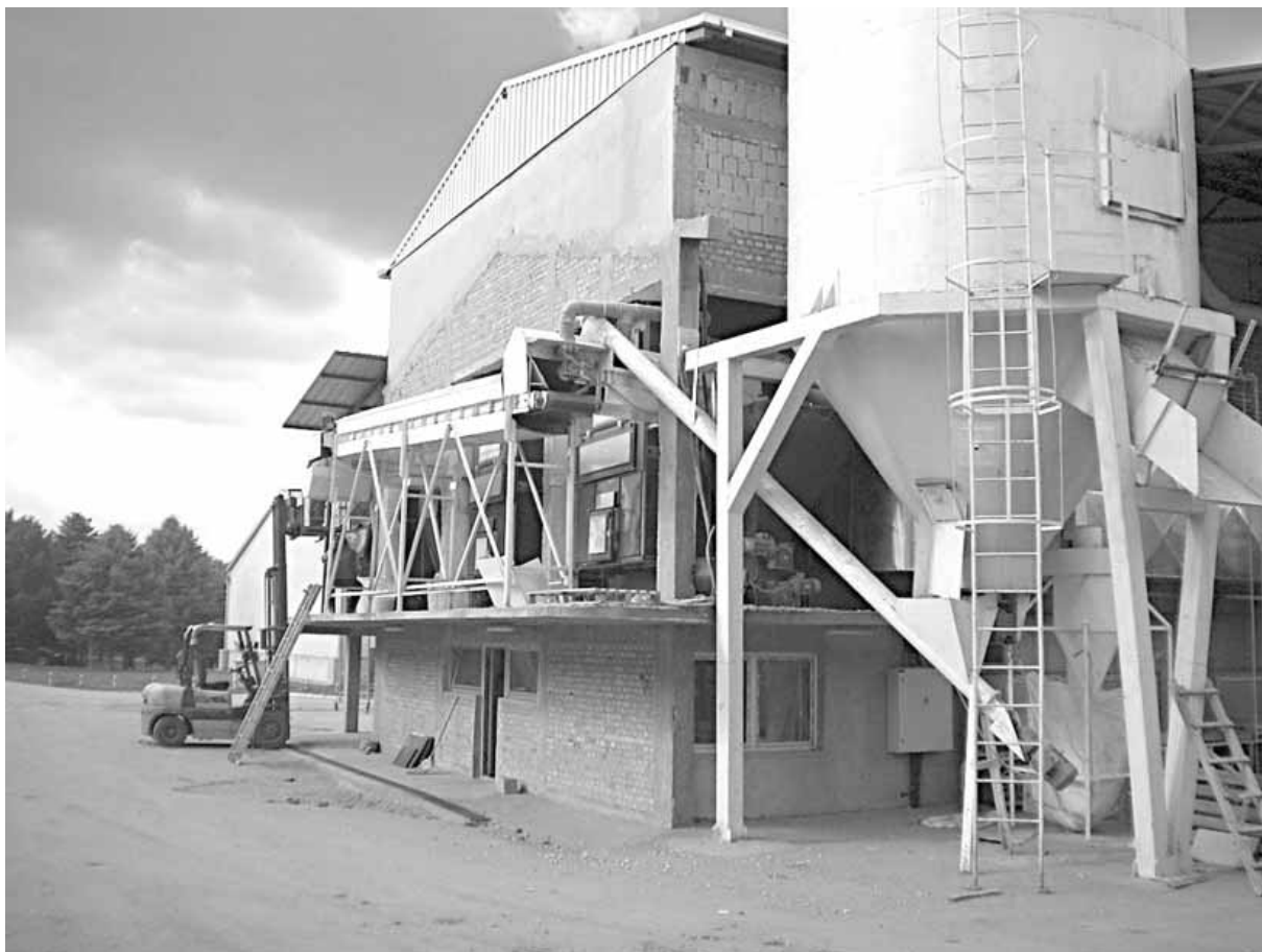
Čelo sušare sa silosnom ćelijom za oklasak i tri termogena
