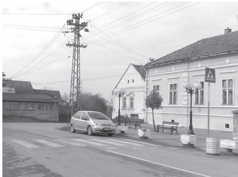
Delimična rekonstrukcija zgrade mesne zajednice u Maradiku
