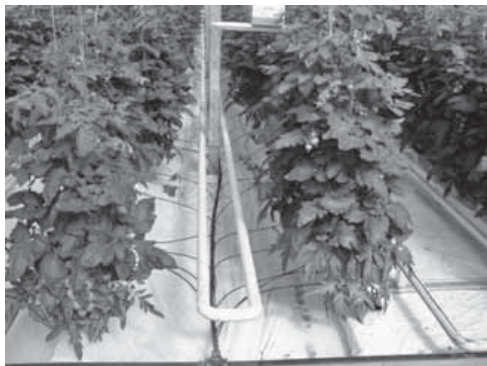
Grejna petlja postavljena na nosače platenika
