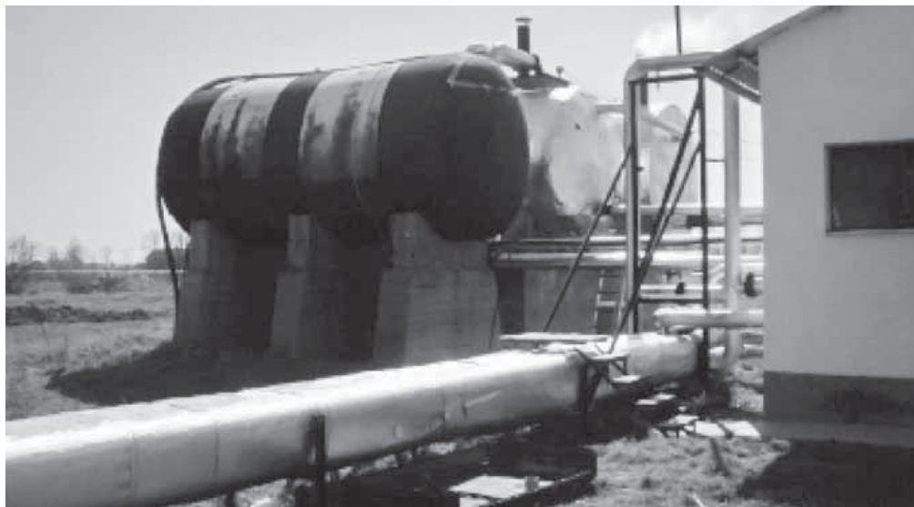
Rezervoari za degazaciju i mešanje GTV
