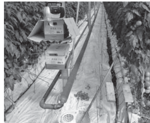
Grejna petlja sa spiralom na desnoj cevi
