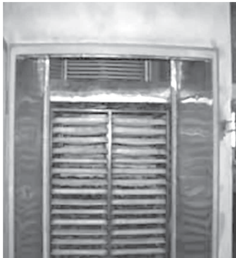
Sl. 4. Vodogrejni kotao na biomasu (bale)
