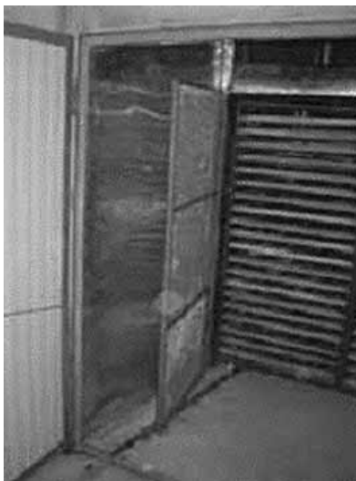
Sl. 2. Recirkulacioni kanal iznad tunela šine, deflektor-dvokrilni sušare
