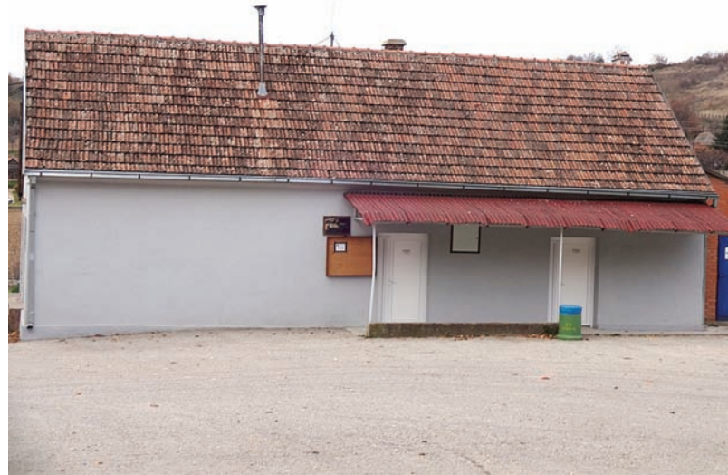
Obnovljena zgrada Mesne zajednice u Šišatovcu
